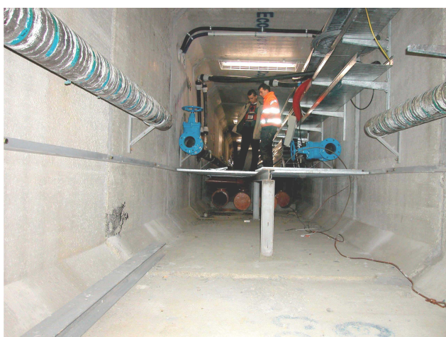
foto 5: fasi di lavorazione
